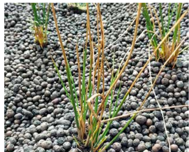
Geëxpandeerde kleikorrels vormen een duurzame basis voor het oeverplantendak.
