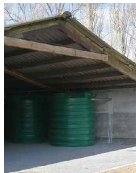
In dit deel van de hoeve bevinden zich twee Phytoparkings met een totale capaciteit van 104 IE, voldoende voor de behandeling van grijs en zwart afvalwater van een volledig bezette camping. (Foto: Rietland)
