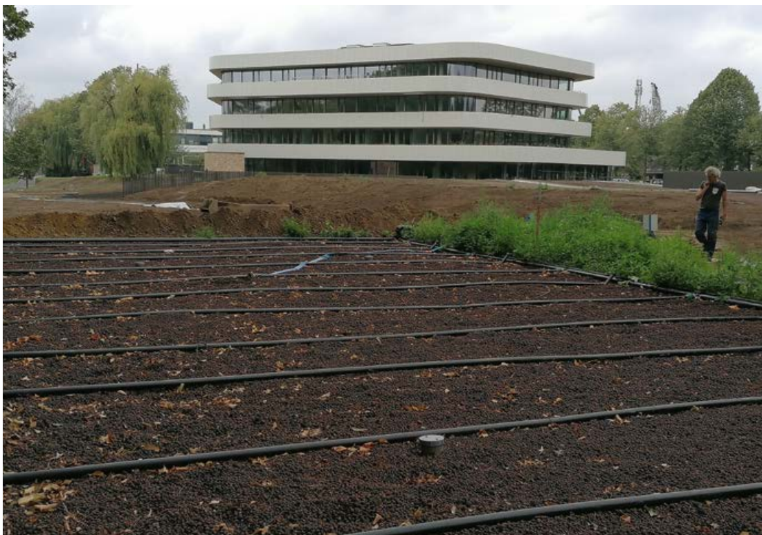
Een belucht rietveld van 250 m 2 volstaat om het afvalwater van Penta, waar 1.700 studenten zullen schoollopen, te zuiveren.
