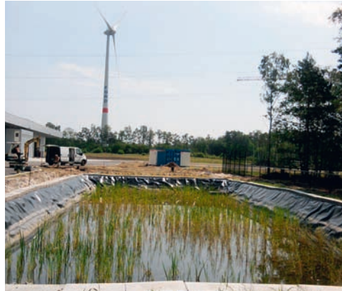
► Het bufferbekken na aanleg
