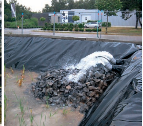
► Twee pompen van elk 75 m 3 per uur voeden het bufferbekken
