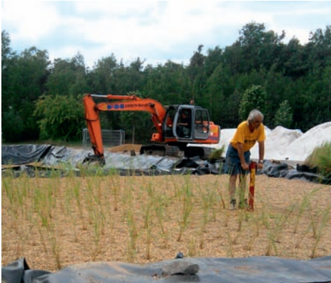
► Beplanting van het percolatierietveld
