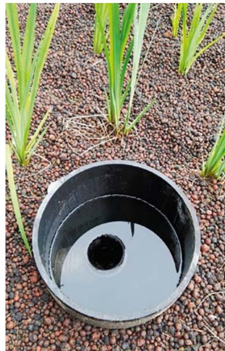
Het vulsubstraat van een belucht rietveld bestaat uit Argex.
